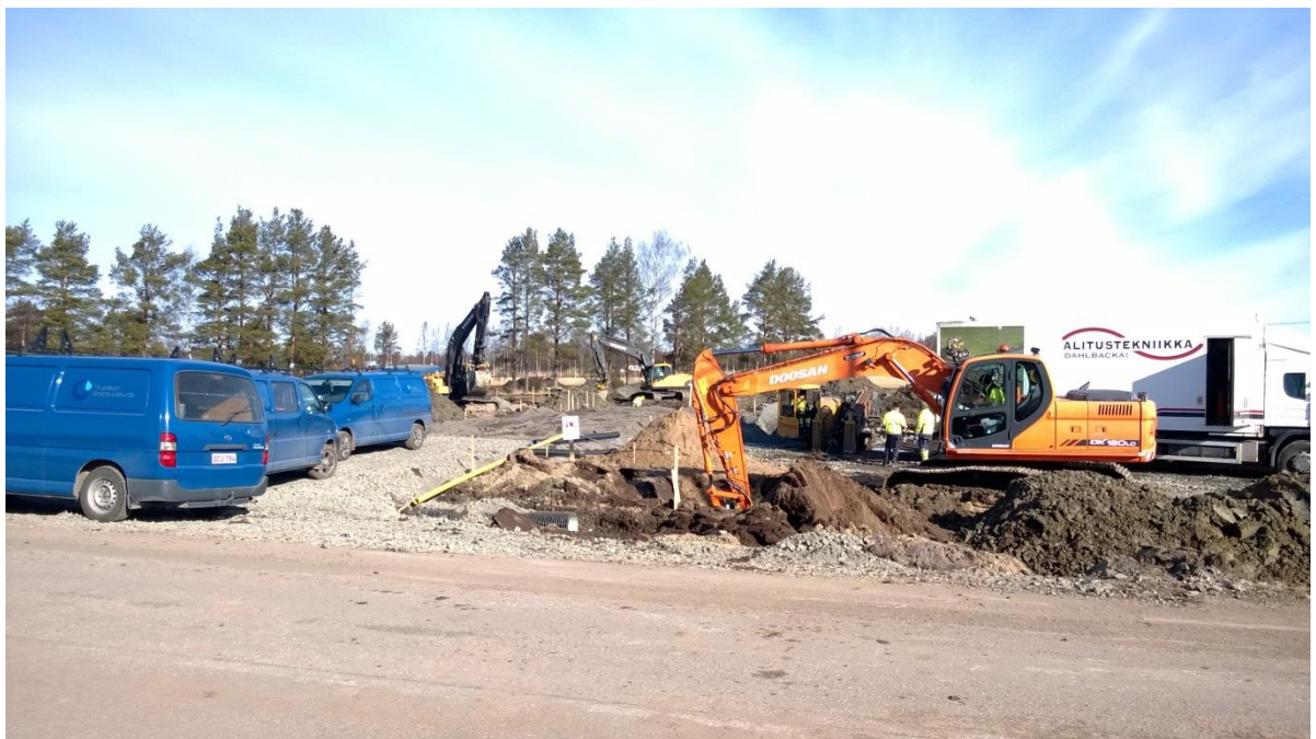
Kuva 6. Olmalan alueen kunnallistekniikan rakentaminen käynnistyi.
