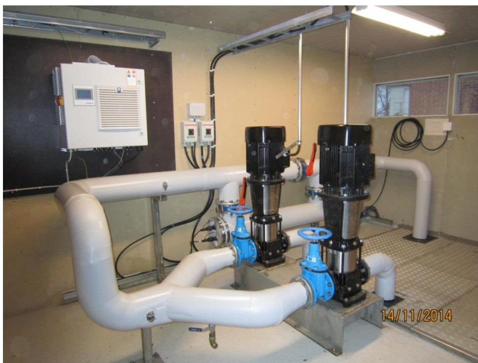
Kuva 1. Johtotien 1000 m 3 säiliön pumput vaihdettiin ja asennettiin UV-laite.
