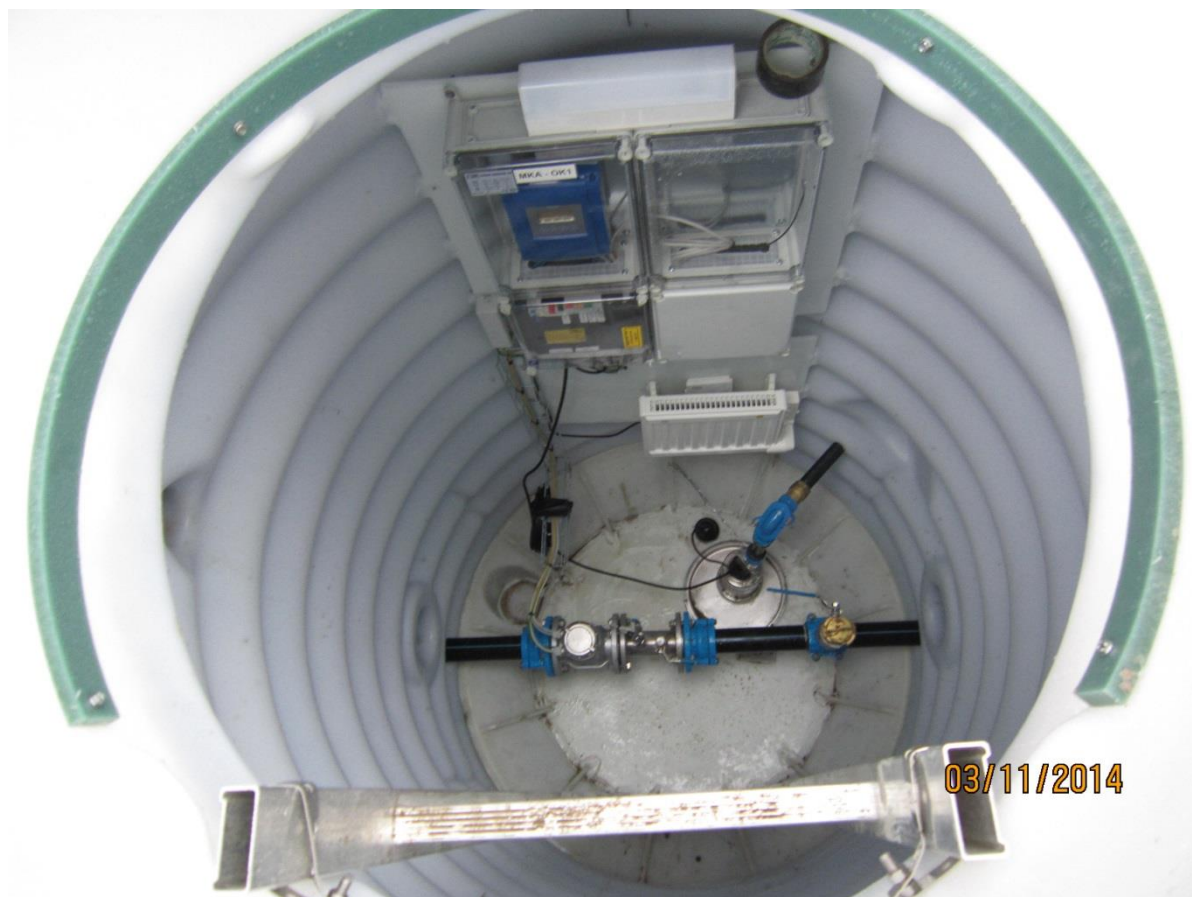
Kuva 3. Uusia mittauskaivoja rakennettiin Sievintielle ja Rajaperälle.
