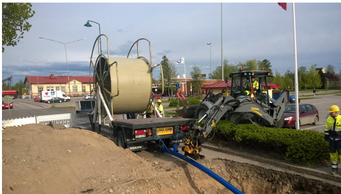
Kuva 2. Asemakadun vesijohdon saneeraus oli vuoden merkittävin saneerauskohde.
