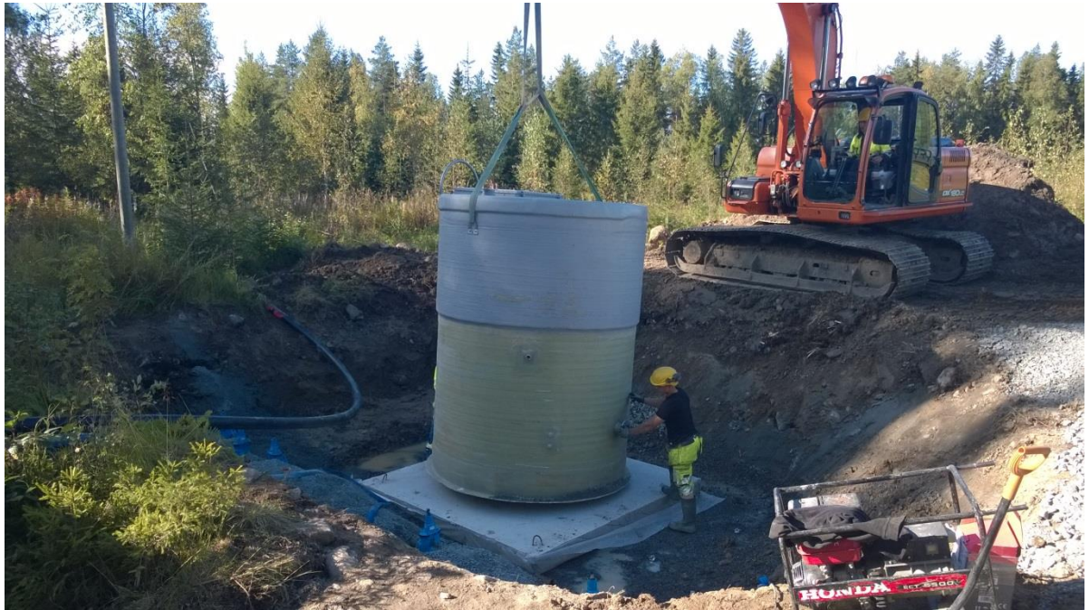
Kuva 4. Tuomiperälle asennettiin paineenkorotuspumppaamo.
