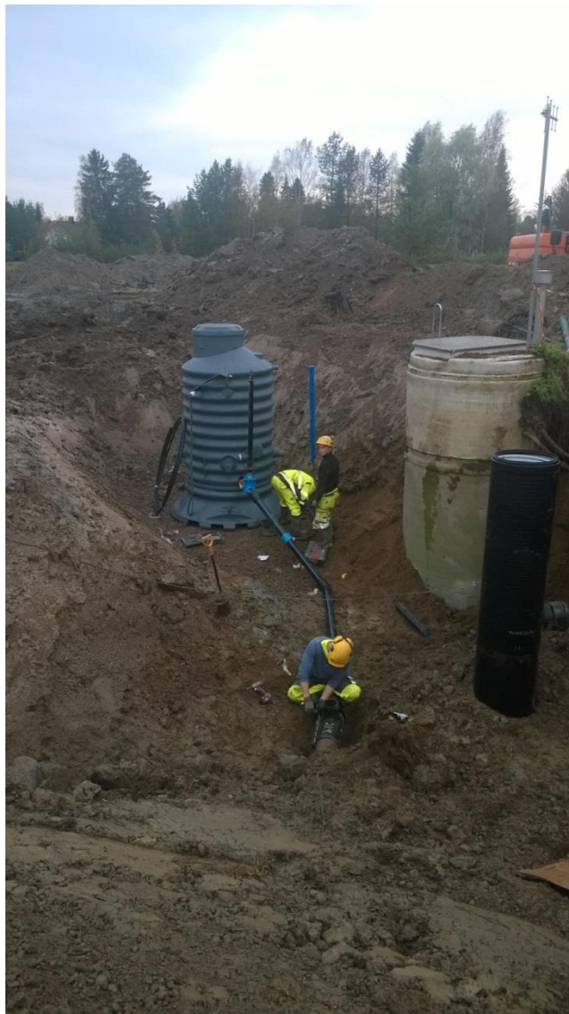
Kuva 5. Radan alituksen vesijohto ja mittauskaivo uusittiin Viljavarasto-Närhtie välille.
