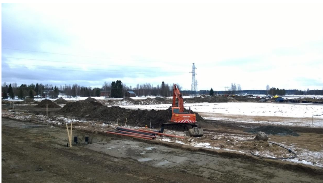
Kuva 1. Olmalan alueen rakentaminen alkuvuodesta.
