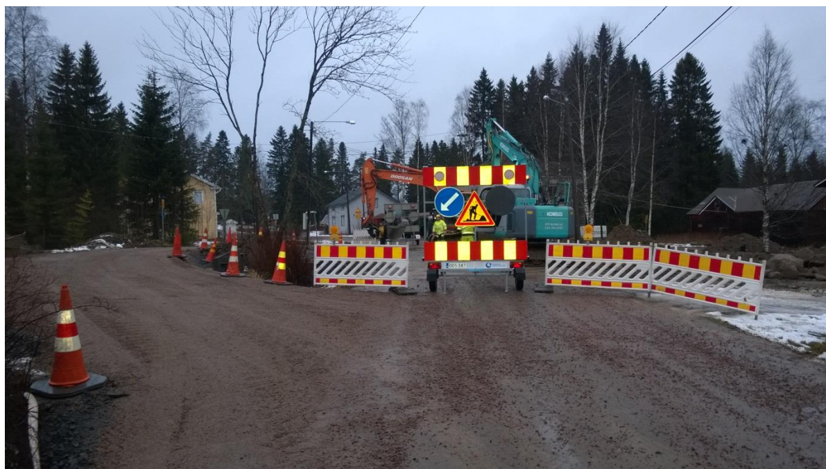
Kuva 3. Viemärointia rakennettiin Raudaskylälle.
