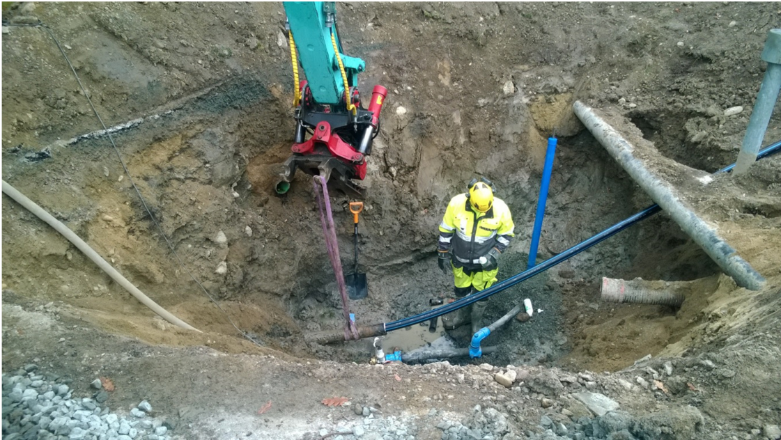
Kuva 3. Sujutusta Naakkatiellä, 75 PEH putki entisen 110 PVC:n sisään.
