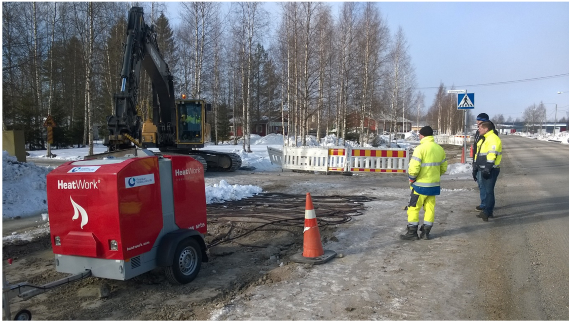
Kuva 4. Uusi roudansulatusvaunu ensimmäisessä kohteessa Korjaamontiellä.
