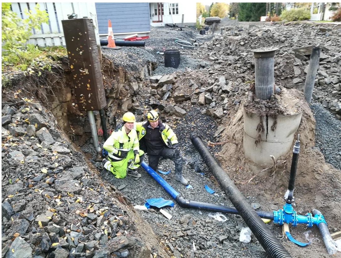
Kuva 3. Palopostin asennus Katajantiellä. Kuvassa vesihuoltoasentajat Petri Konttila ja Juha Vähäkangas.
