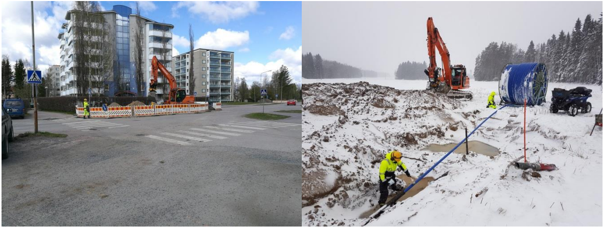
Kuva 1. Verkostoa saneerattiin edelleen aktiivisesti. Kuva Vieskankadulta.
